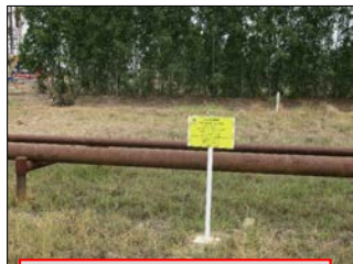
ป้ายสะท้อนแสงแสดงขอบเขตแนวท่อ ของโครงการ
