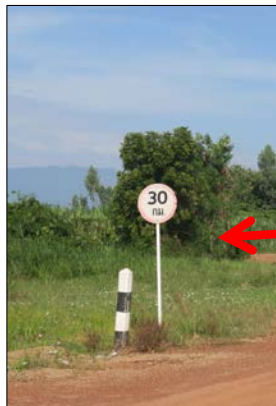
ป้ายสะท้อนแสงแสดงขอบเขตแนวท่อ ของโครงการ
